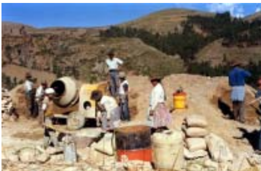
Camperols bolivians construint un dipòsit
