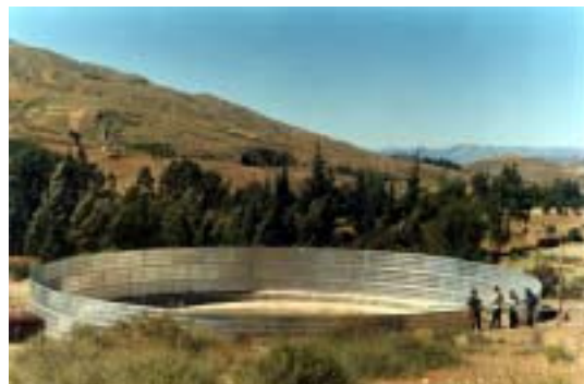
Vista general d'un dipòsit acabat
