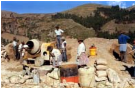
Camperols bolivians construint un dipòsit
